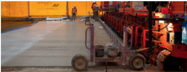
Abb. 7.10: Einbau von XPOSAL 105 mit Fertiger.
