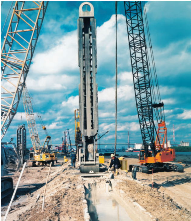
Abb. 10.2: Dichtwand mit Solidur Containerterminal Hamburg Altenwerder
