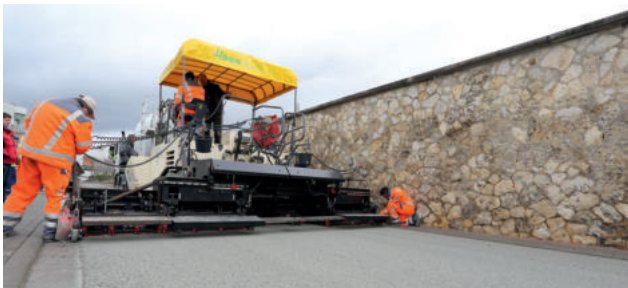
Abb. 9.2: Straßenfertiger mit modifizierter Verdichtungsbohle
