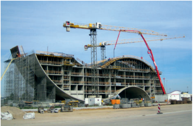
Abb. 6.3: Baustelle Verwaltungsgebäude ENERCON
