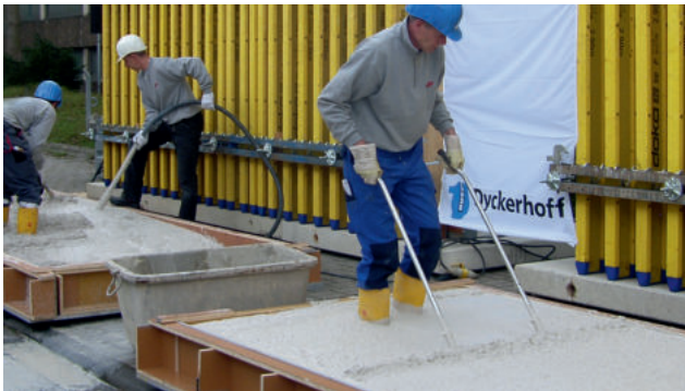
Abb. 7.3: Verdichtung FLUIDUR im Vergleich zu Normalbeton
