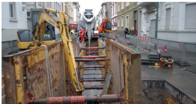
Abb. 9.1: Einbau Dyckerhoff CANADUR
